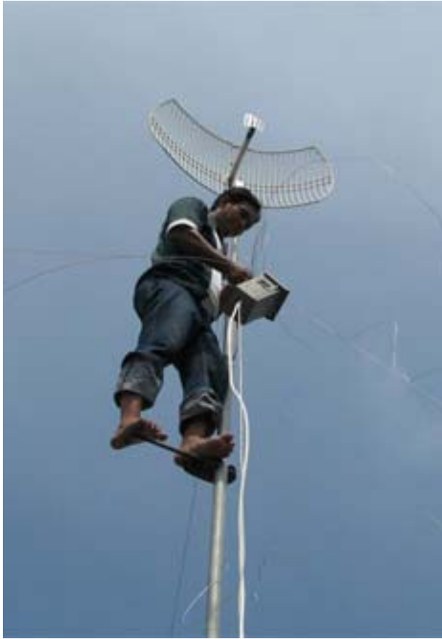
Setelah pemasangan tower internet, dilakukan juga pemasangan radio internet point to point
